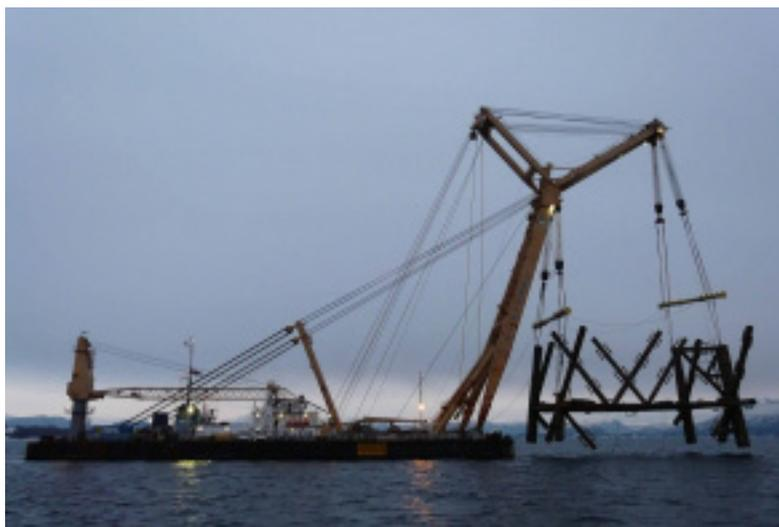
*Figura 21. Fase di sollevamento del deck (Fonte: engineerlive.com)*
