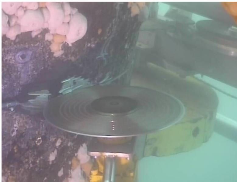
*Figura 20. Fase del taglio dei pilastri immersi della piattaforma
