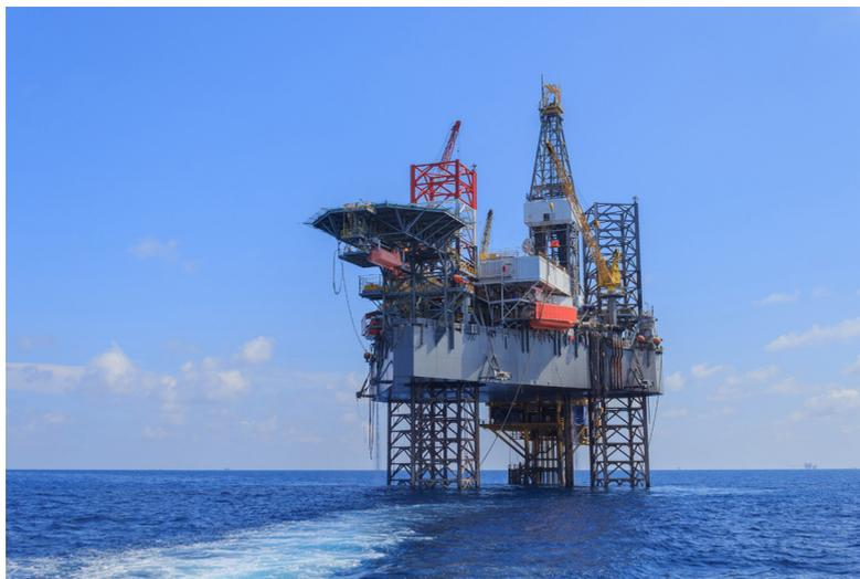
Figura 12. Esempio di una piattaforma Auto Sollevante
